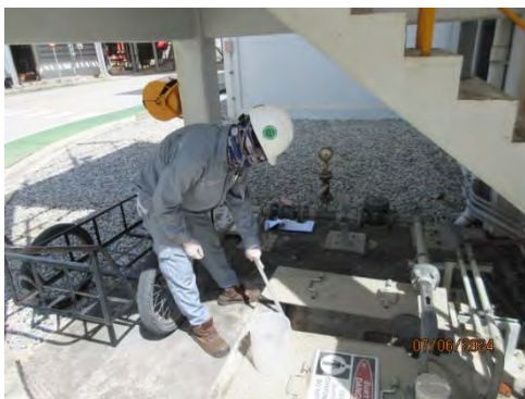
บ่อพักน้ำเสีย (Inspection Pit) (V100-2-U) ขนาด 1 ลบ.ม. (SW3)
